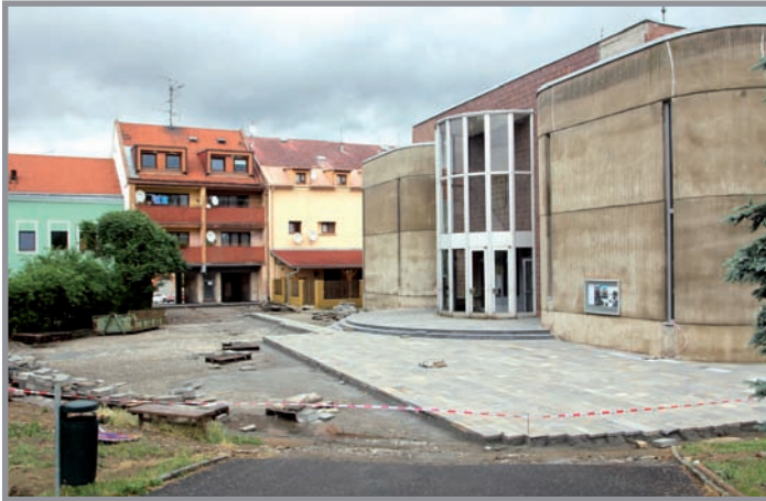
Fotografie z prací na projektu vydláždění a úpravy okolí kulturního domu
