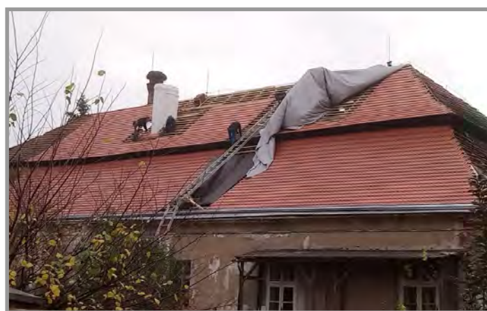
Rekonstrukce střechy - severní křídlo historické budovy dostalo letos v listopadu novou střechu
