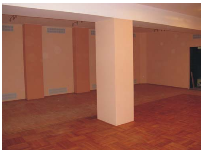
Oprava vinárny KD 2008
