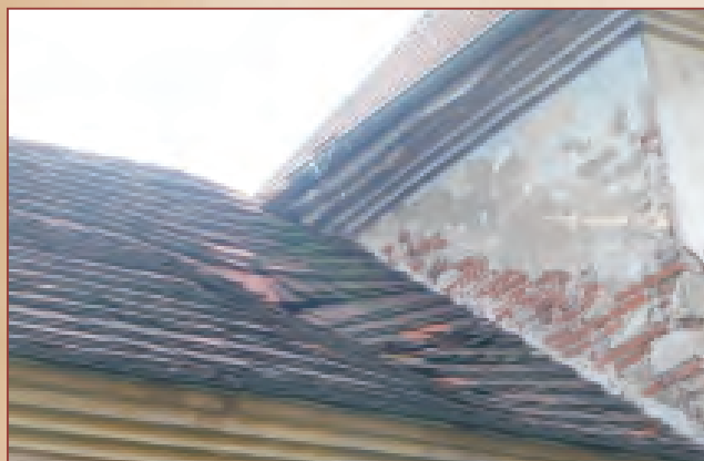
Střecha na domě č. p. 10 (r. 2011)
