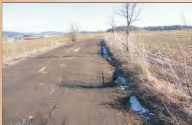
Komunikace Martinice – Březnice (r. 2012)
