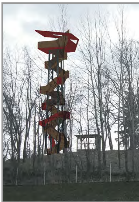
Ocelonosná konstrukce, dřevěná schodišťová ramena, výška mezi 25 a 26 metry
