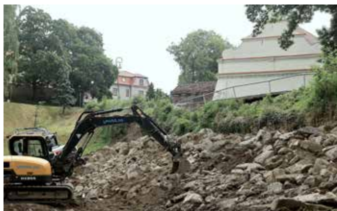
V červnu započala sanace bortícího se valu pod komunikací kolem zámku.
