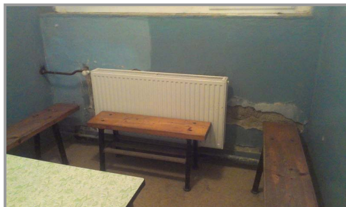
Šatna před rekonstrukcí
