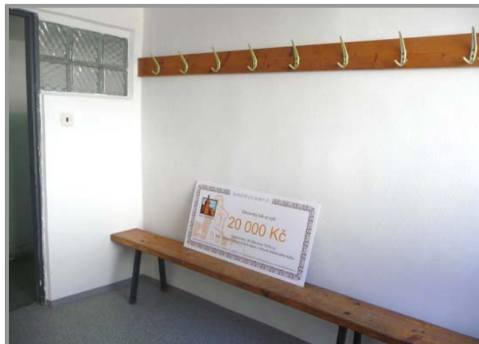
Šatna po rekonstrukci
