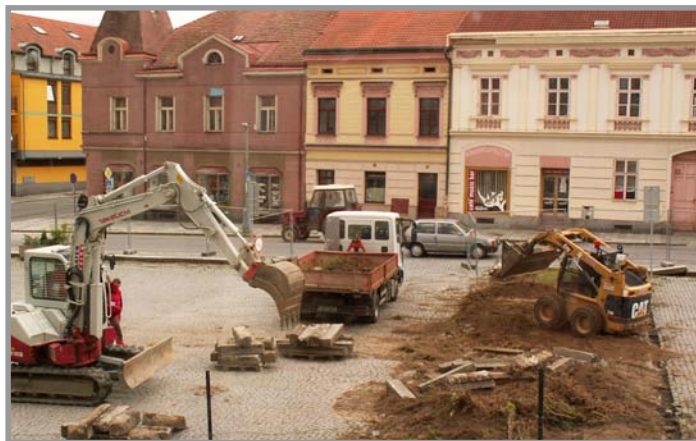
První etapa rekonstrukce Náměstí
