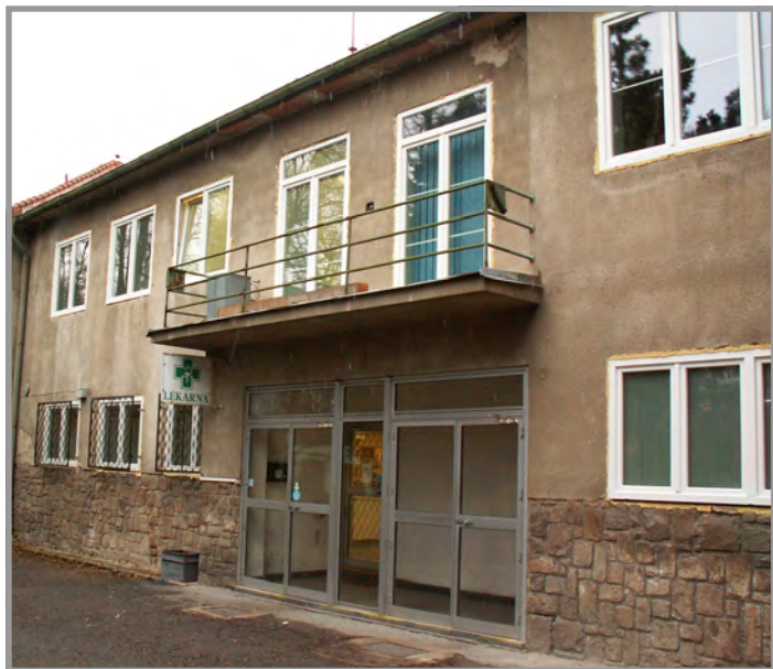
Výměna oken v budově staré polikliniky
