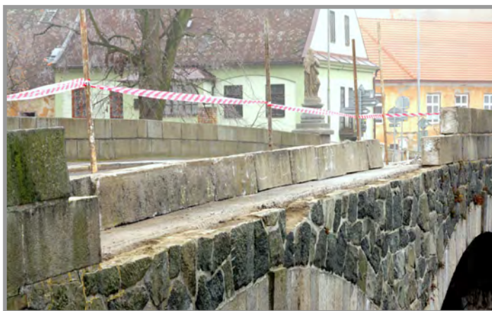
Rekonstrukce mostu přes řeku Vltavu Foto F. Slaník
