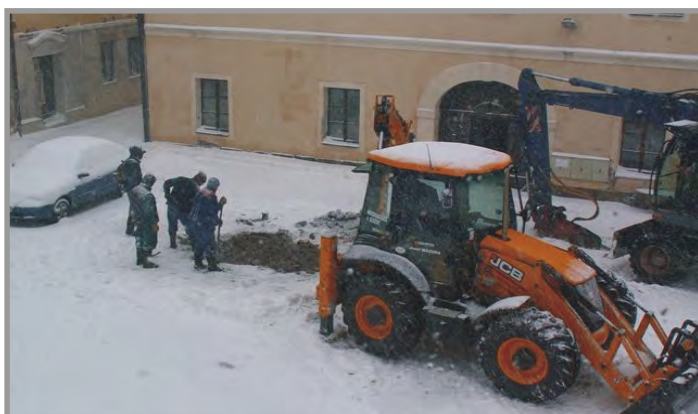
Oprava prasklého vodovodního potrubí v Lokšanech
