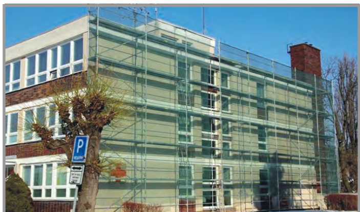
Zateplování polikliniky v Sadové ulici
