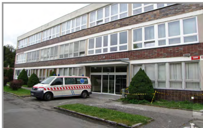
V budově MěZZ probíhá výměna oken Foto Městská knihovna
