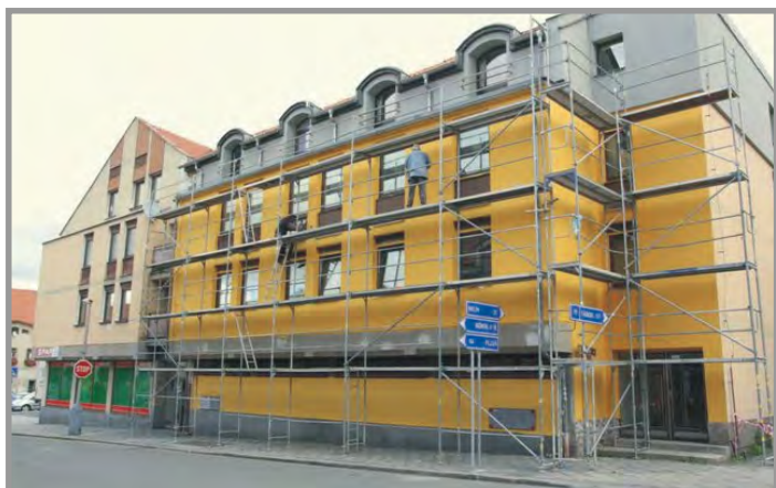
Opravy fasád na městských domech Foto F. Slaník
