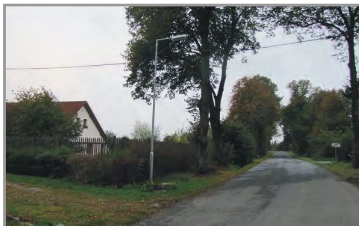
Nové veřejné osvětlení v obci Bor Foto Městská knihovna
