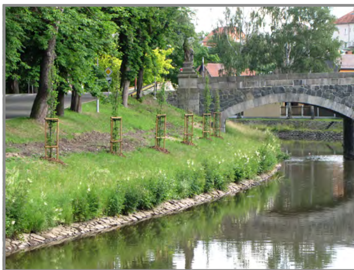
Historická úprava nábřeží
