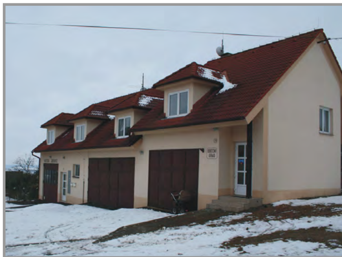
Zrekonstruované stodoly – centrum kulturního dění ve Vševelech
