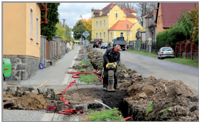
Výstavba osvětlení v ulici Ludvika Kuby
